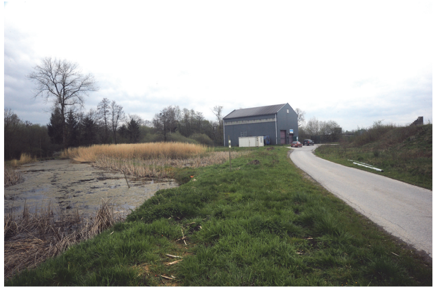
Station d'épuration photo : C. Cassimans
